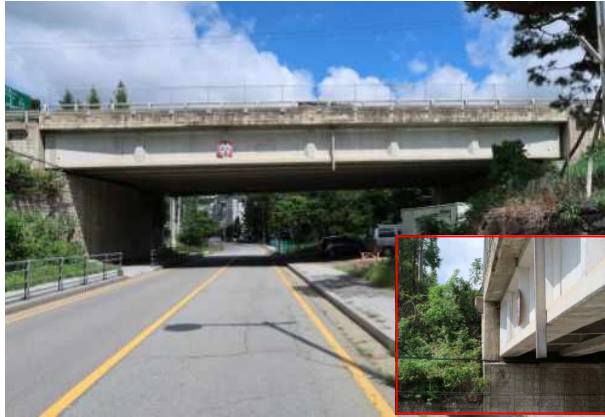
하천용 배수구 전경
