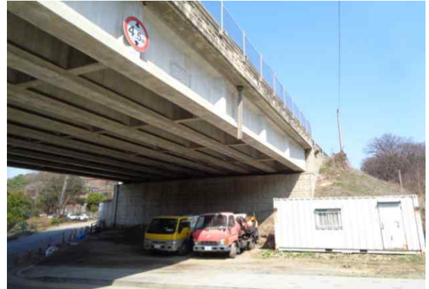
하천용 배수구 전경
